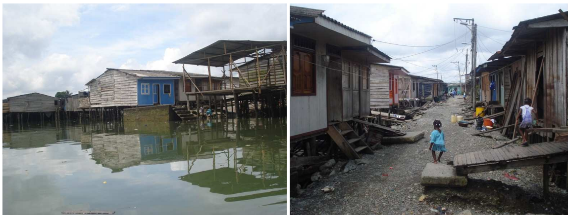
Figura 5.1-2. Viviendas paratíficas en Buenaventura que carecen de infraestructura de saneamiento básico.
