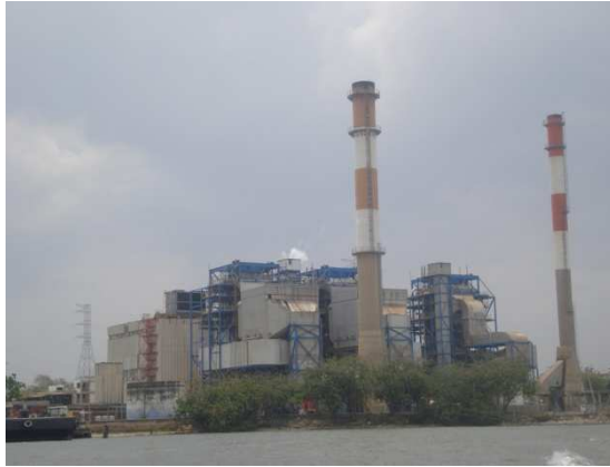
Figura 4.1-7. La zona industrial de Mamonal reúne diversidad de instalaciones de tipo manufacturero y de producción.
